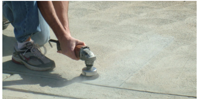
Grind surface. Pulir la superficie.
