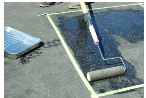
Apply primer within marked area. Aplicar tapaporos en la area delineada.
