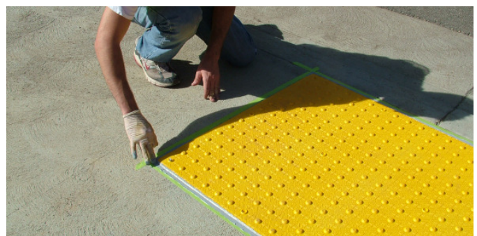
Apply sealant around outside edges of tile (for concrete only). Aplique sellador al rededor del borde del azulejo (en el hormigon).
